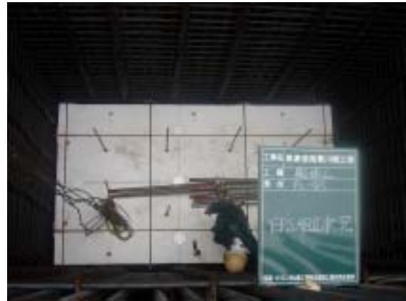
写真 - 3 組立状況
