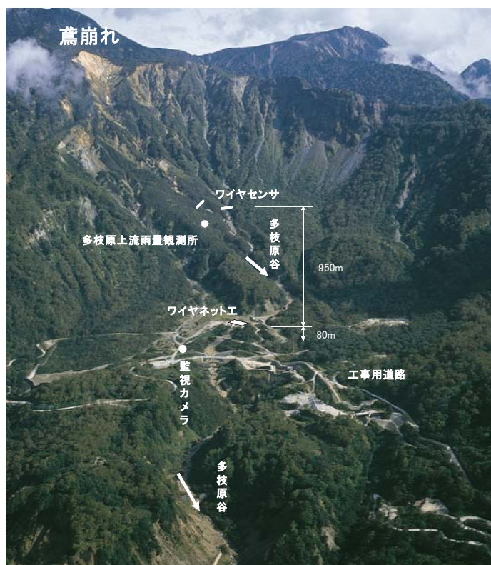
写真-1 ワイヤネット工の設置
