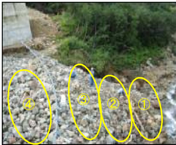
写真－2 先端部での捕捉状況
