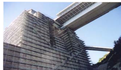
写真-1 アンカーレージの総枠組足場
