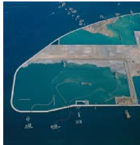
写真-1 施工中の空港島
