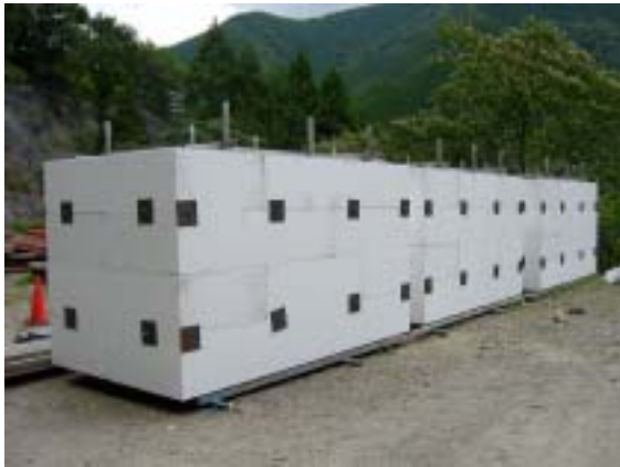
写真 - 2 大組状況
