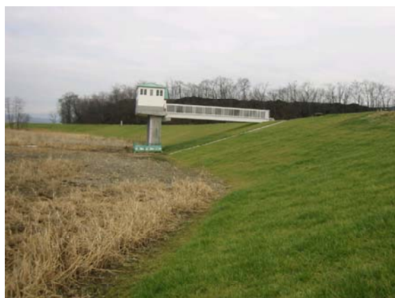
写真－4 吹付後堤防植生状況
