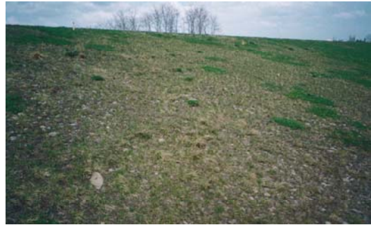
写真-1 衰退した堤防植生状況
