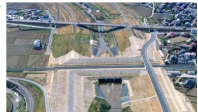
図-2. 完成状況写真
