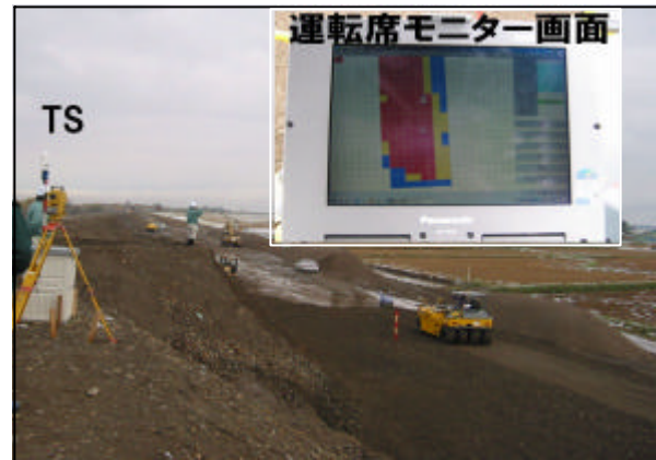
写真 - 4.1 実証試験施工状況
