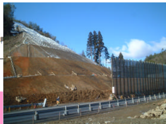
写真 - 5 . 1 施工状況
