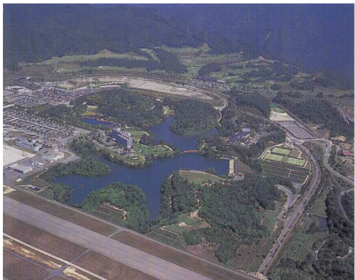
「庭園空港都市」というコンセプトで整備された広島空港
