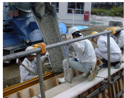
写真-2 打設状況 (フィールド実験)
