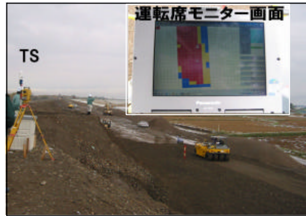
写真 - 4.1 実証試験施工状況
