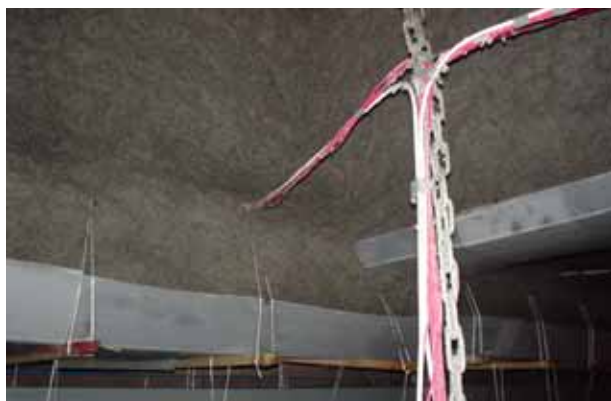
写真-4 脱塩状況
