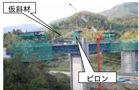
写真-1 ピロン支柱及び仮斜材
