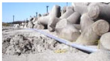
写真-3 排砂管敷設状況
