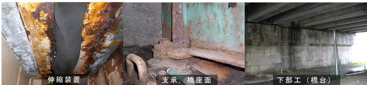
図-1 桁橋の主な損傷写真
