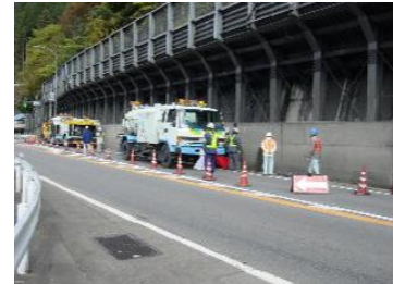
写真-1 作業状況 (車両を連ねた状態での規制)
