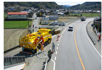
写真-4 作業現場状況 (最小限の交通規制状況)
