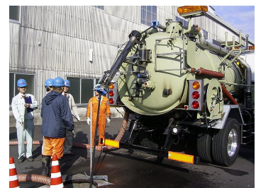
写真-3 性能試験状況
