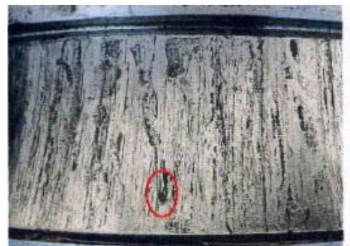
写真-5 軸受内部転動面錆状況
