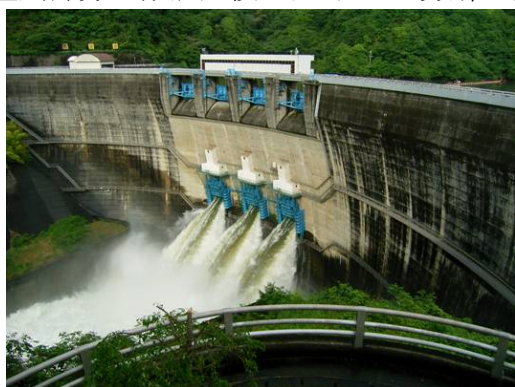
写真-1 天ヶ瀬ダム
