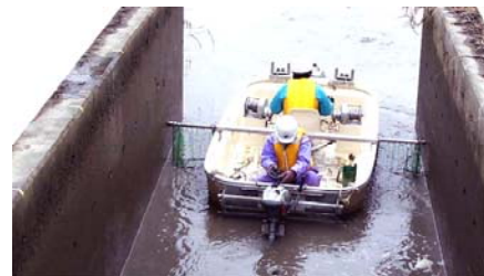
写真-1 簡易排除装置実証実験状況
