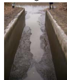
写真-5 排除後ガタ土状況
