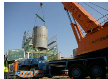
写真-3 鋼管ソケット設置
