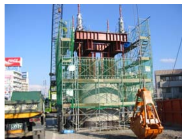
写真-2 オープンケーソン施工
