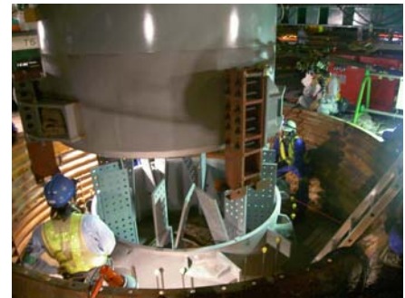
写真-5 橋脚基部の連結部
