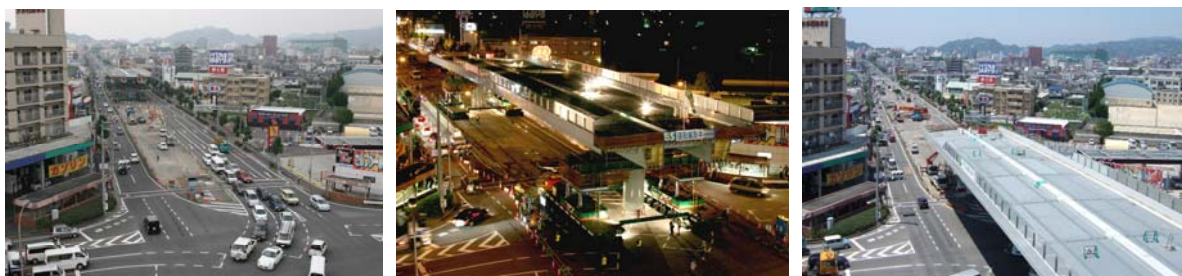
【地組立及び基礎完了】
