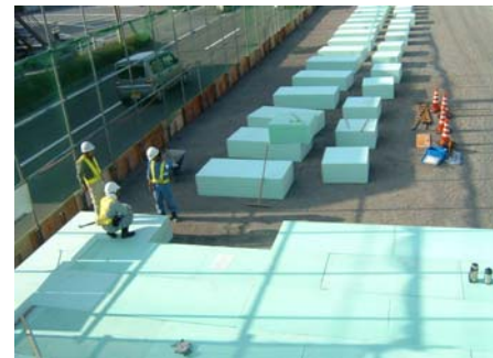
写真-6 EPS軽量盛土の施工
