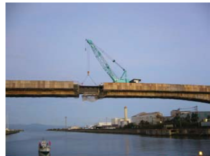
写真2 閉合ブロックの架設状況
