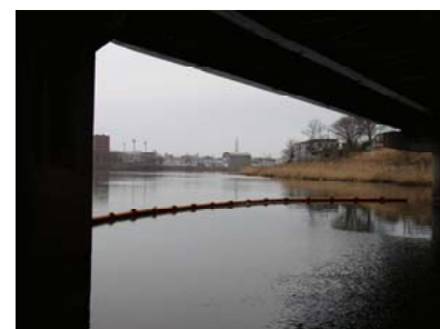
仮設工：汚濁防止フェンス
