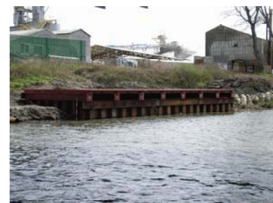
仮設工：台船船着場
