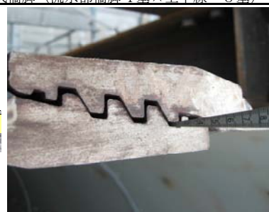
写真-1 かみ合わせ継ぎ手(断面)
