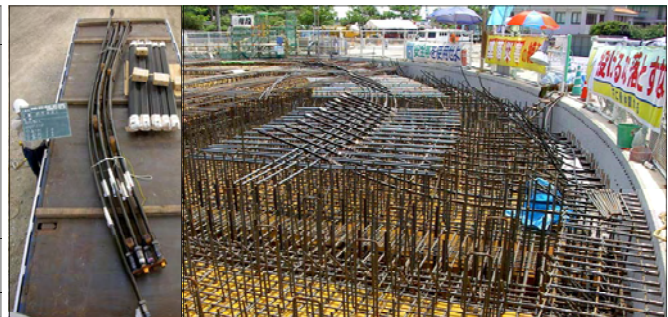
写真-2 設置ユニット及び設置状況〔床版部〕
