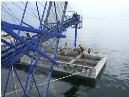
写真-2 ミキサー船打設状況
