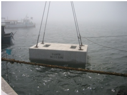
写真-1 ブロック海中据付状況
