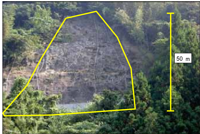
写真-1 堂ヶ原防災工事箇所全景
