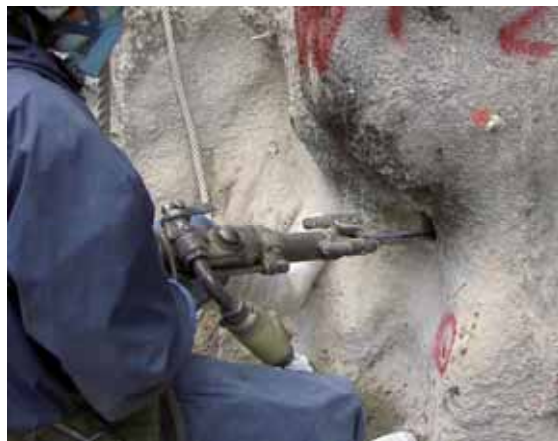
写真-4 鉄筋挿入工写真(削孔)
