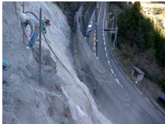
写真-3 施工写真
