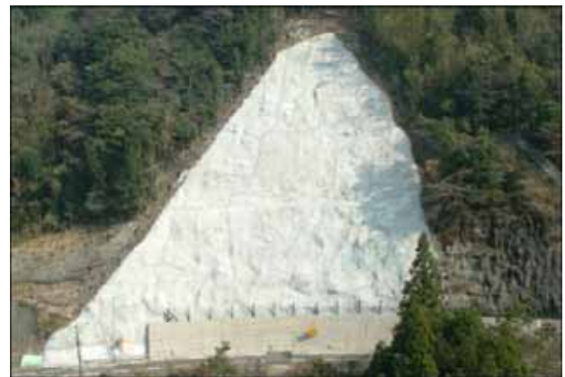
写真-5 完成写真
