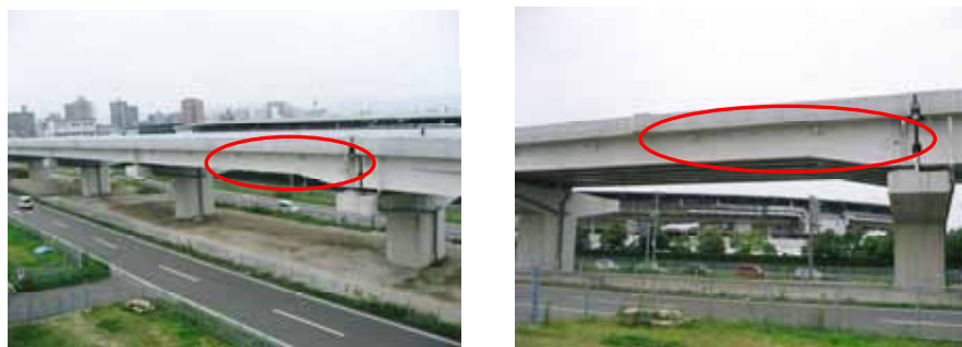
写真 - 3 架設完了状況
