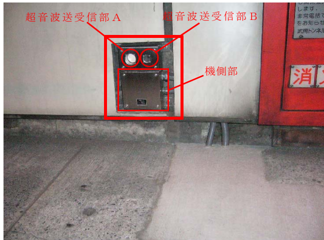
図 3 : 超音波センサーの原理
