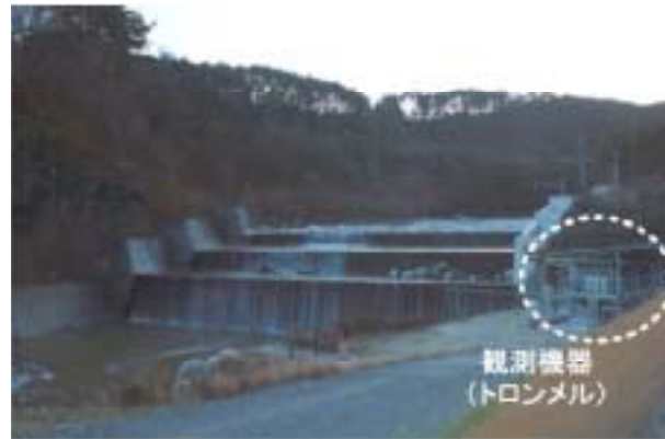
写真 - 2 有人固定式観測機器の例（トロンメル）
