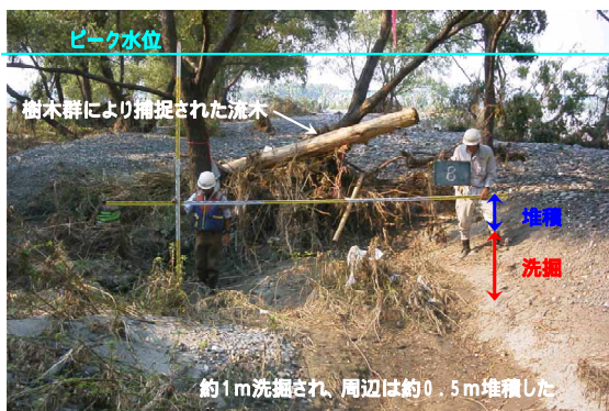
写真 - 3 樹木群に捕捉された流木と 洗掘・堆積状況
