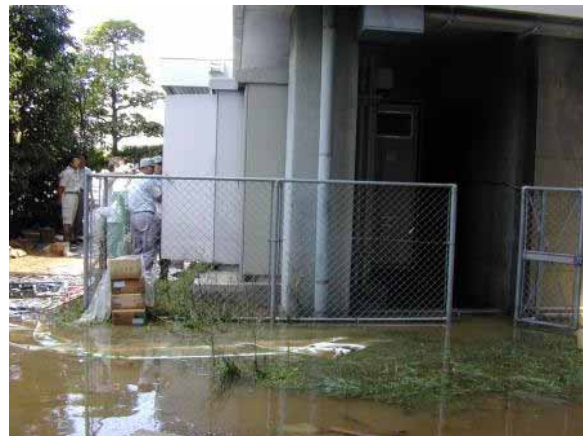
写真 3.5 屋外用受変電設備の点検状況
