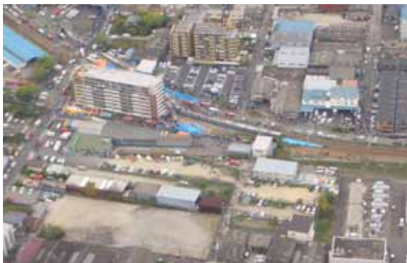
写真 3.11 きんき号による上空からの調査
