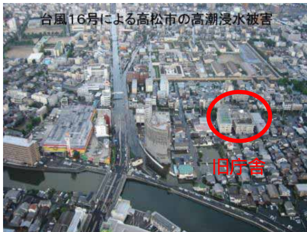
写真 3.3 高潮浸水被害
