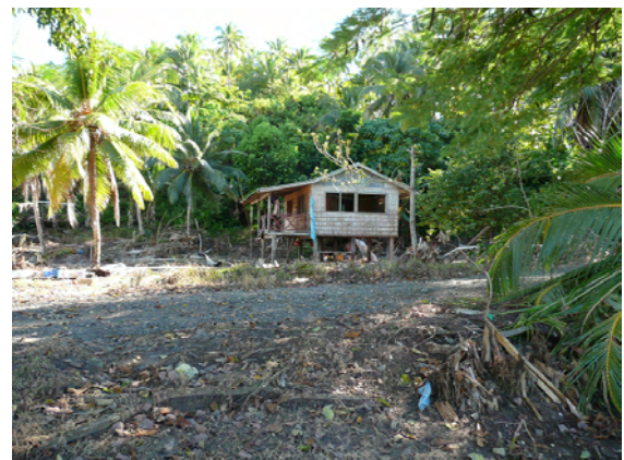
写真-6：津波による流出から免れた高床式住居。高床の下の部分を津波が通り抜けたため流失を免れた。
