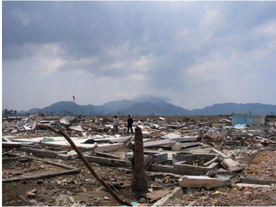
写真-1: スマトラ島北部のバンダアチェにおける被害。海岸線から 2~3km の範囲は写真に示すように住居などが壊滅し、5km 離れた内陸まで海水が到達した。
