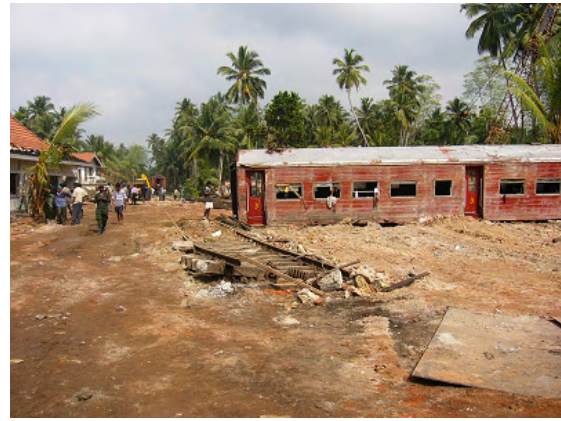
写真-2: スリランカで被災した列車。津波の第 1 波目で列車に逃げ込んだ住民を含め 1000 名以上が津波の第 2 波目により犠牲になった。
