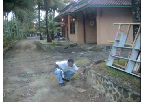
写真-4：地盤高が高かったため5mを越える津波でも床下浸水にとどまった地区である。
