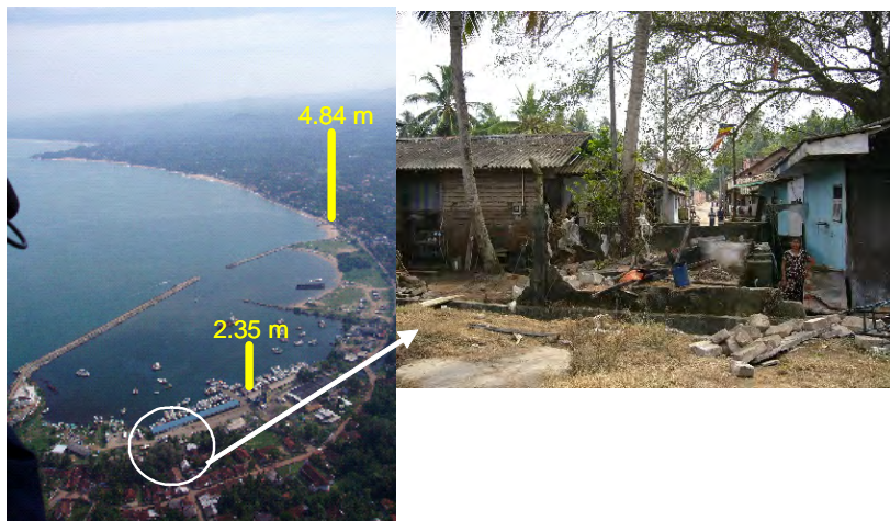
写真-3: スリランカ、ベルワラ漁港における津波被害の軽減。防波堤などの港湾施設により津波が低減され、漁港では陸上 0.7m 程度の浸水深に抑えられ、背後の村落の壊滅的な破壊は免れた。左の写真中の数値は海面からの津波の痕跡高さである。
