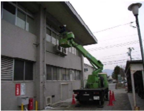
写真-1 高所作業車を使用した外壁打診調査
