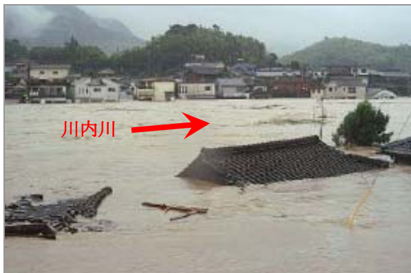
写真-1 川内川中流部さつま町市街地付近の被災状況
