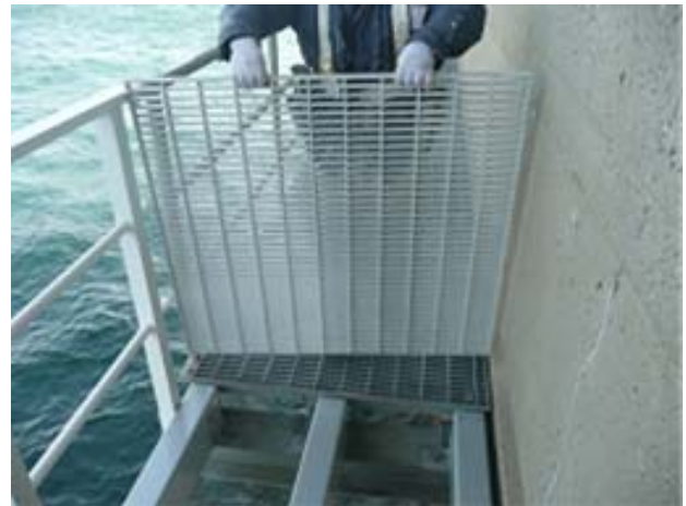
写真-6 FRP製管理路の設置作業
