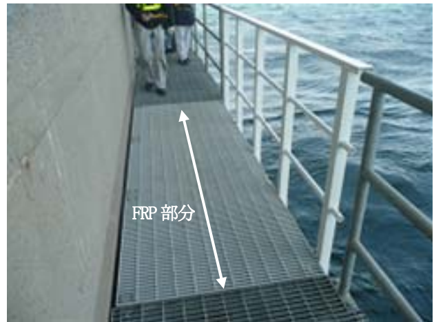
写真-5 FRP製管理路の設置状況
