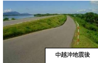
図-8 中条地区の対策工施工前後の状況
