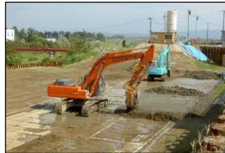
図-6 中条地区の液状化対策工
