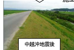
図-9 本与板地区の対策工施工前後の状況
