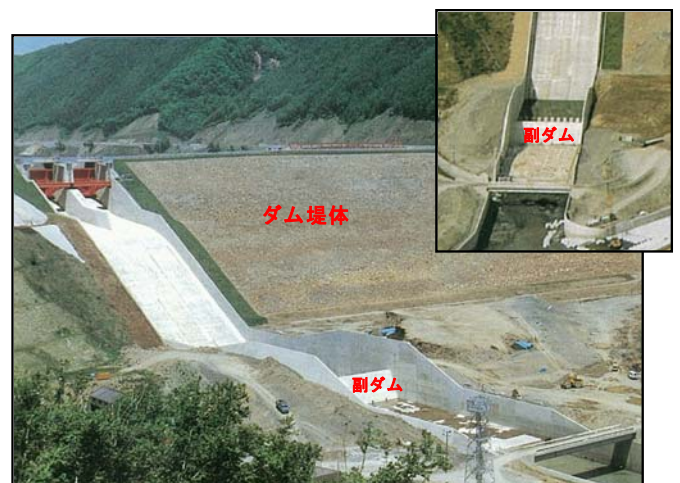
【写真-2】 跳水式減勢方式 (十勝ダム)
