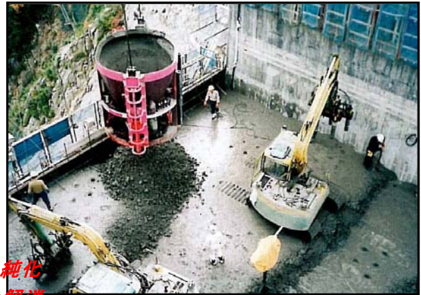
【写真-6】鉛直構造の施工状況 (温井ダム)
