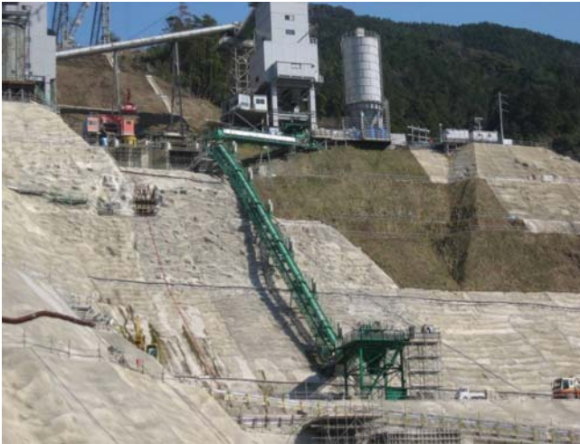
【写真3：コンクリート運搬（SP-TOM）】
