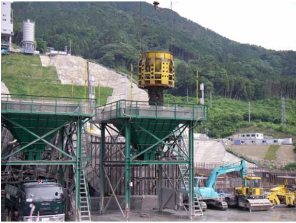
【写真2：コンクリート運搬風景】
