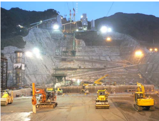
【写真4：夜間打設風景】
