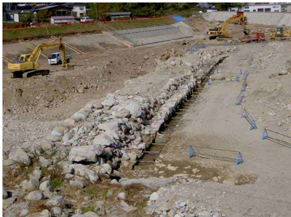
写真6 全貌を現した理兵衛堤防
