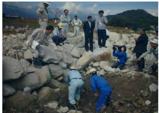
写真5 人力による掘削作業
