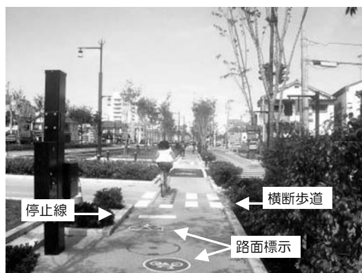
写真-1 古町入舟地区で整備した自転車道（交差点部の様子）
