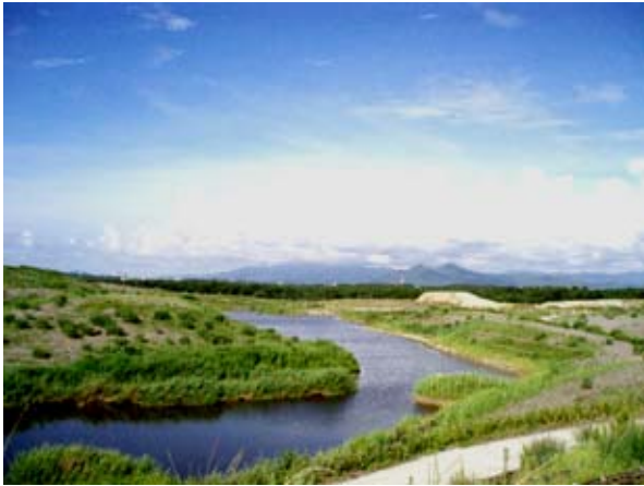
写真-1 「環境共生の森」造成中の現況
