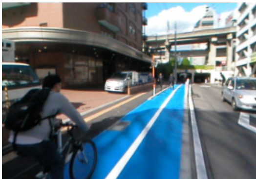
写真 3. 自転車専用帯の敷設状況
