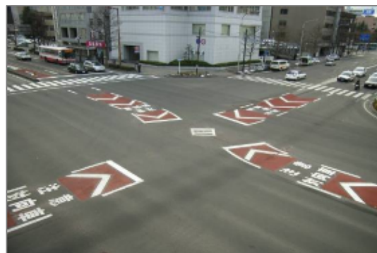
写真 2. 交差点部右折導流レーンのカラー化
