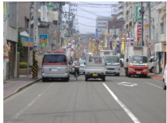
写真 5. 自転車走行レーン施工前
