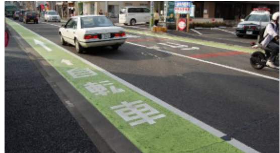
写真 4. 自転車走行レーンの敷設状況
