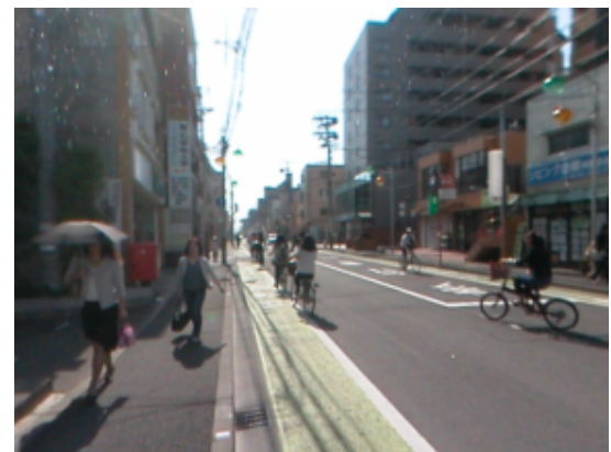
写真 6. 自転車走行レーン施工後
