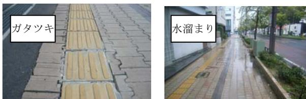
写真-2 劣化損傷
