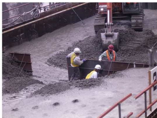
写真1 打止め型枠の設置状況
