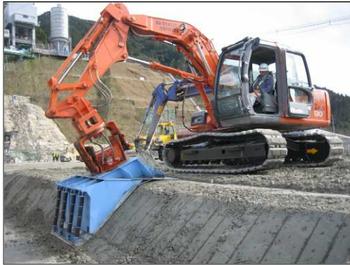
写真3 法肩締固め機
