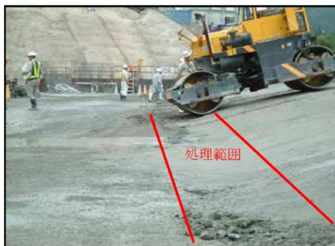
写真5 傾斜打止め状況
