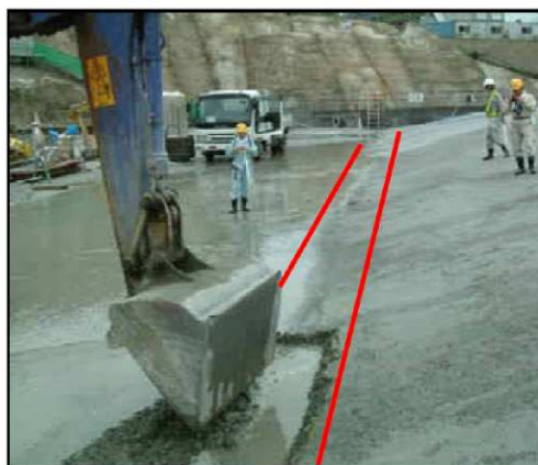
写真6 エッジ処理状況
