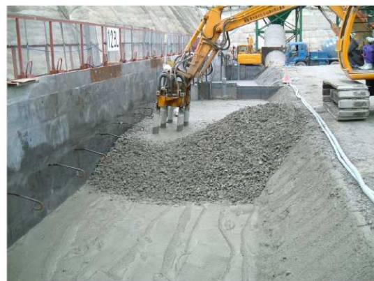
写真2 外部コンクリートの打設状況
