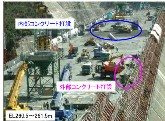
写真7 巡航状態における打設状況
