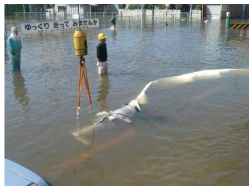
写真-1 高潮被害における排水ポンプの設置
