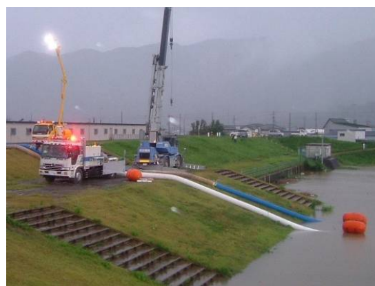
写真-7 排水ポンプ車設置状況
