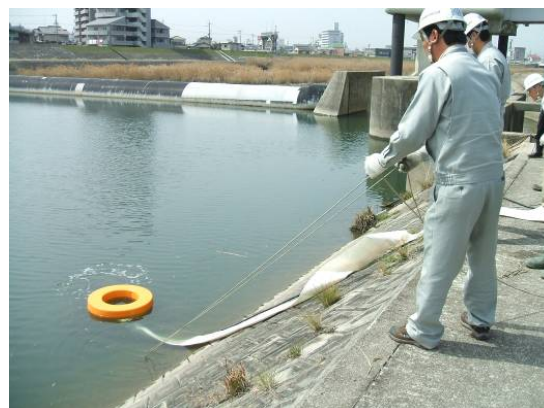
写真-9 着水・離脱の状態
