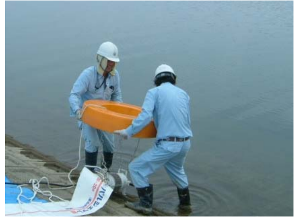
写真-2 排水ポンプの投入(訓練時)
