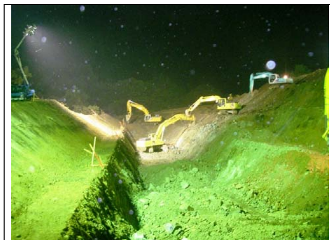
図－7 夜間施工状況
