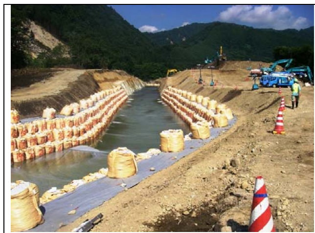
図－9 仮排水路完成
