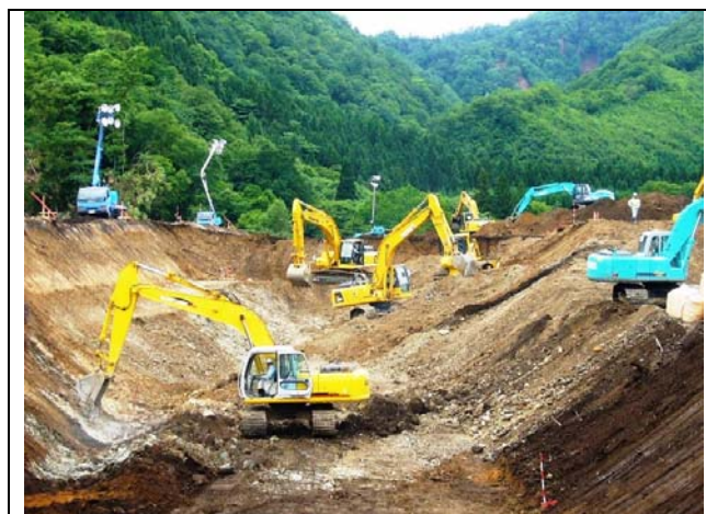
図－8 河道掘削状況
