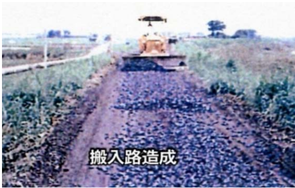
写真-7 搬入路施工に割栗石を使用 昭和56年小貝川高須地先緊急復旧工事
