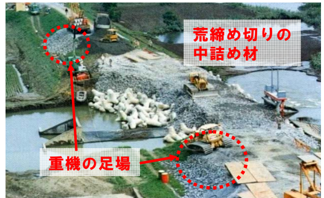
写真-6 荒締め切り・重機の足場に割栗石を使用 昭和56年小貝川高須地先緊急復旧工事
