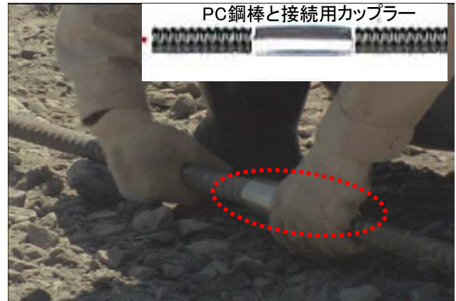
写真-5 PC鋼棒を代用したタイロッドの設置 昭和56年小貝川高須地先緊急復旧工事
