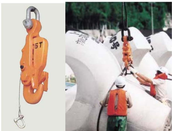
写真-9 根固めブロック吊り上げ時にオートフックを活用した事例 (メーカーホームページ)
