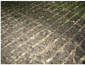
写真-2 滑走路表面の状況
