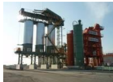
アスファルトプラント能力 360 t/h (2基×180 t/h)
