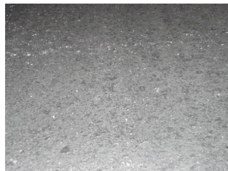
写真-6 大粒径アスファルト舗装の表面
