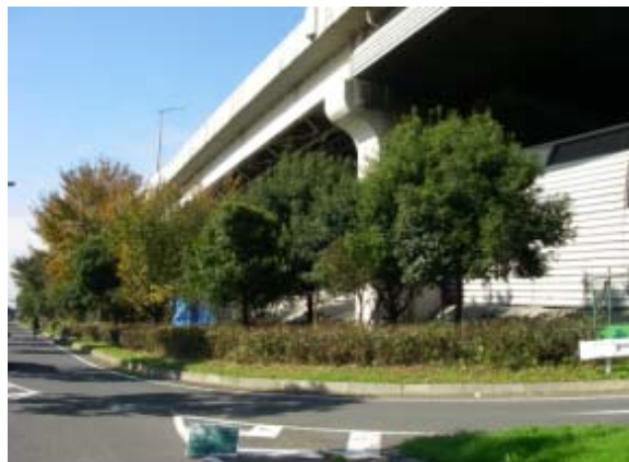
図-7 緑地帯の状況（ホームレス不法占拠箇所）
