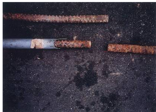
写真-2 破断面部(PC鋼棒:1-9孔)
