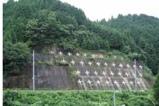
写真-6 対策工事後
