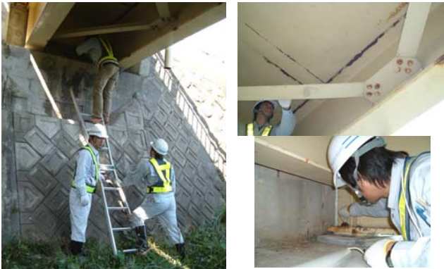
写真-1 直営点検試行の風景
