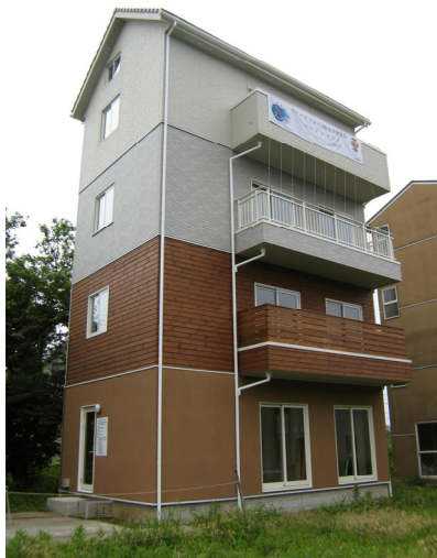
写真-1 実大実験住宅外観
