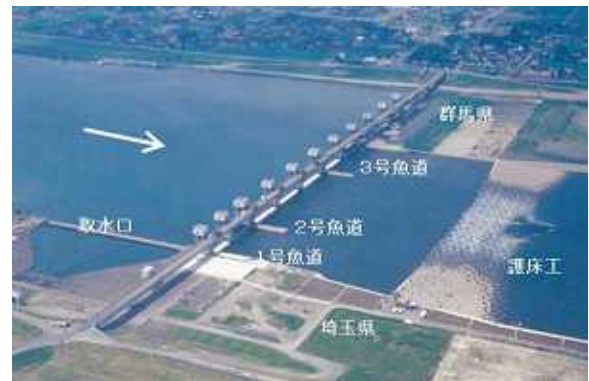
図-1 利根大堰と魚道
