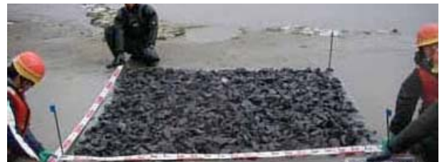
図-16 砕石(2号・密)の設置状況
