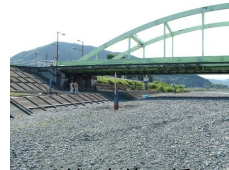
手越(安倍川橋) (河床勾配1/212)
