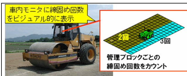
写真-3-2-3 TS・GPSによるローラの締固め管理技術
