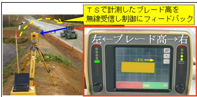
写真-3-2-1 マシンコントロールの建設機械
