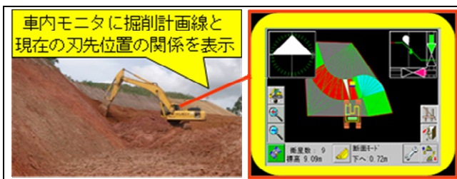
写真-3-2-2 マシンガイダンスの建設機械
